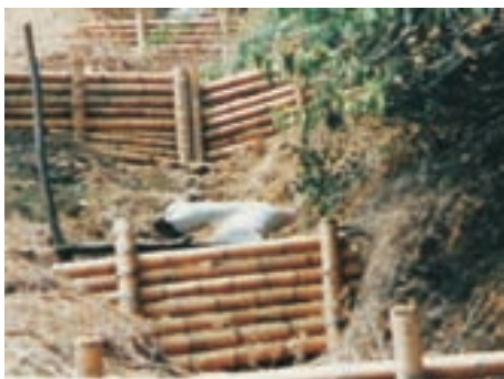
barreras de bambú en cárcavas
