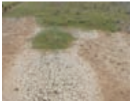
el exceso de humedad
