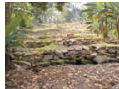
barreras de piedra en cañada
